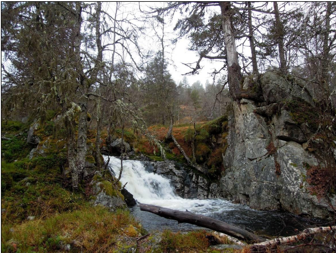
Figur 4.1. Bilde fra inntaksområdet. Foto: Leif Appelgren.
